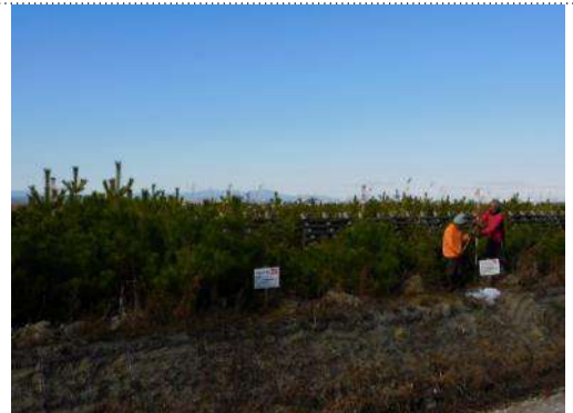
撮影：2022年11月 *大排水溝の排水口工事後
